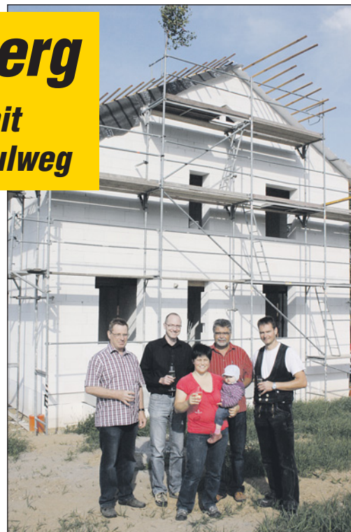
Nach dem Hammerschlag zum Richtfest: Die Geschäftsführer der Firmen Quandt, E. Quandt (l.v.l.), SAKU Massivhaus, Gerhard Kunze (2.v.r.) sowie der Zimmerei Lange, H. Lange, stoßen mit der Bauherrenfamilie auf gutes Gelingen des Bauvorhabens an.
